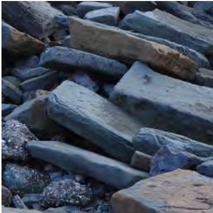
Blocchi di pietra arenaria esistenti - masegni (area spiaggia)
